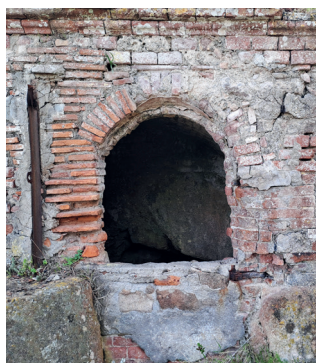
Il sistema dei canali di drenaggio delle acque meteoriche e l'accesso ad una cisterna di raccolta dell'acqua, nell'area dell'ex Colonia Penale (foto di Sofia Mannelli)
